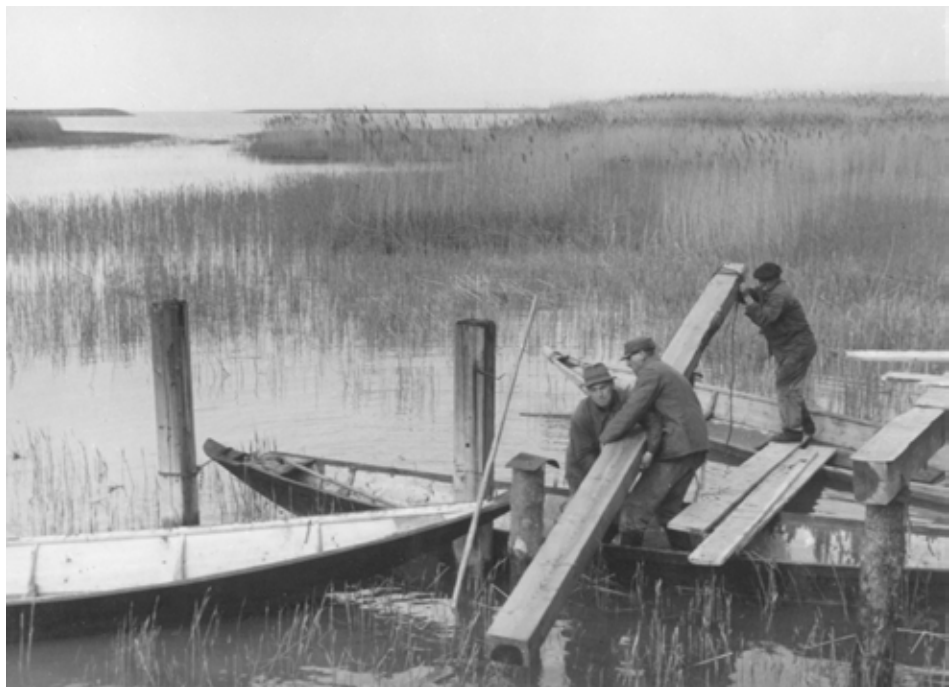
Die Errichtung und Ausbau der Biologischen Station erfolgte 1949/1950 vorwiegend von Zillen aus in aufwändiger und kräfteaubender Handarbeit.
