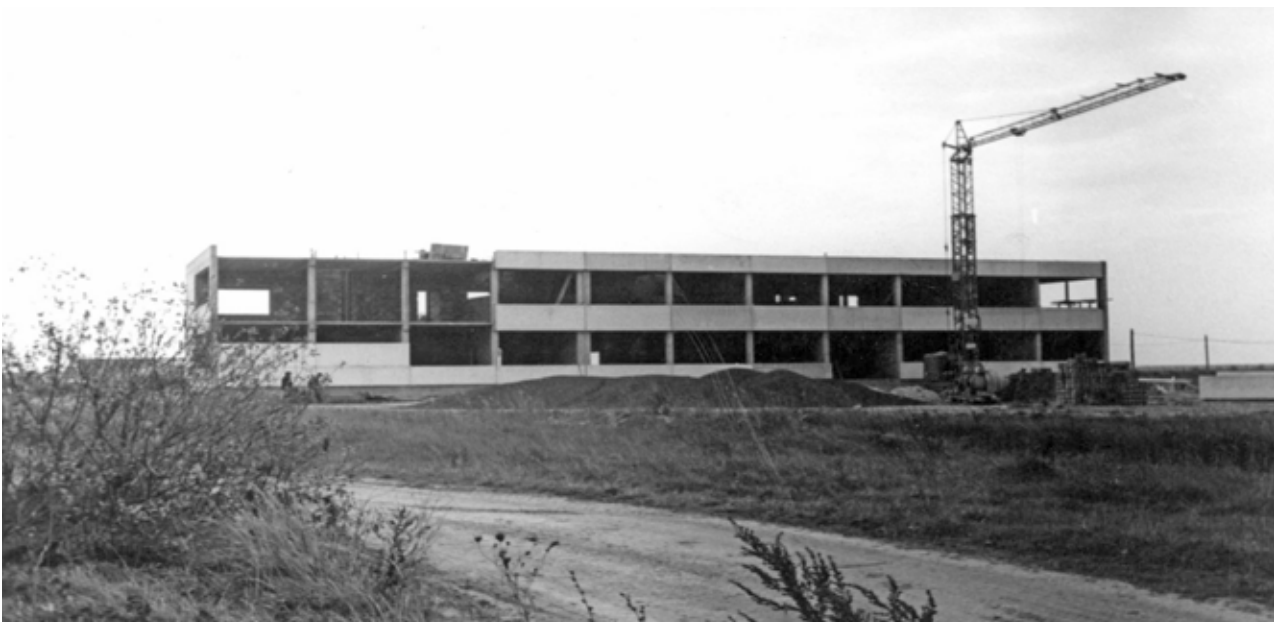
Der Bau des Nordtrakts 1970/1971
