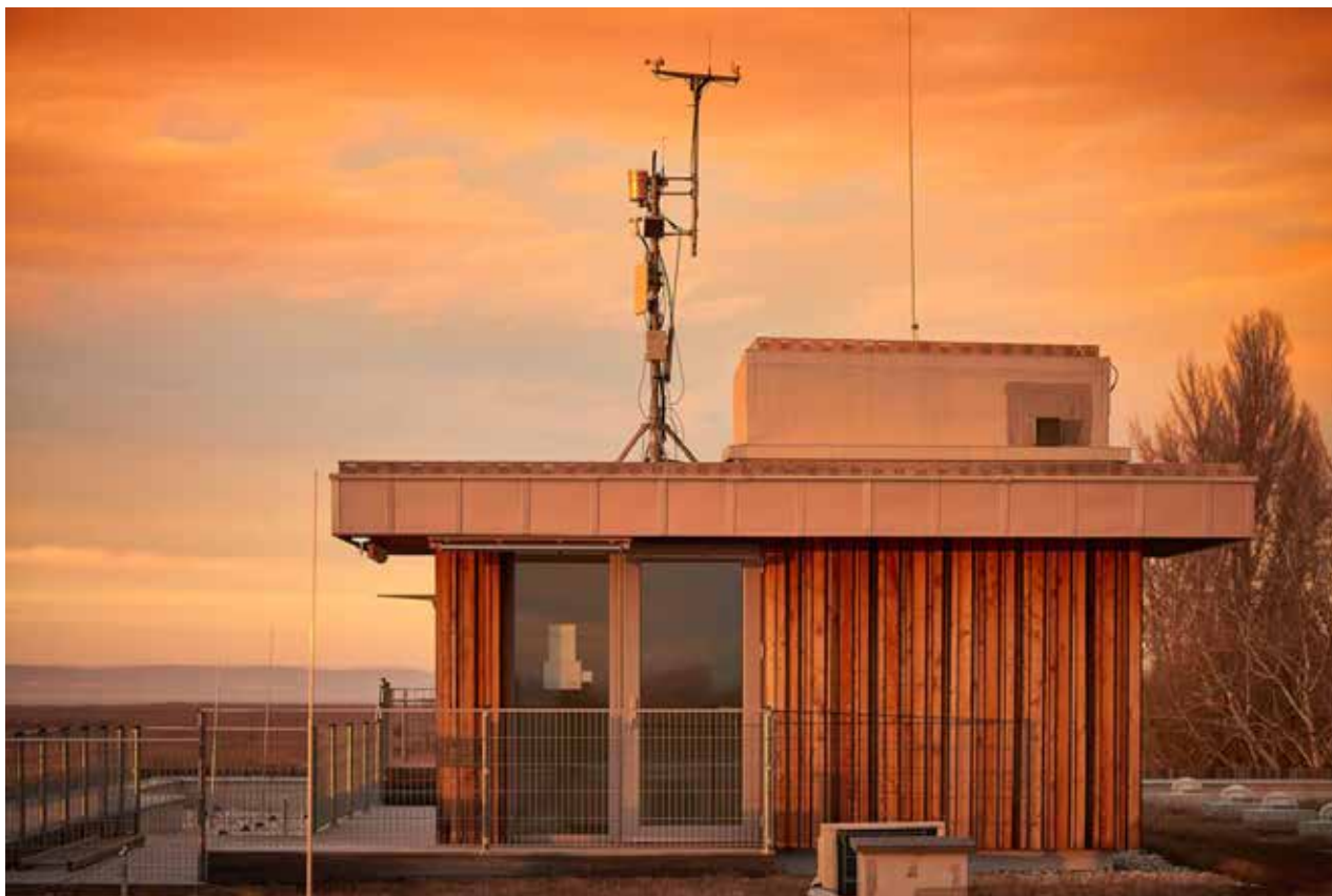
Die Detektorstation am Dach der Lift-Einhausung der Biologischen Station erfasst sämtliche Daten der OnLine-Messsonden, die in den Salzlacken und am Neusiedler See positioniert sind.
