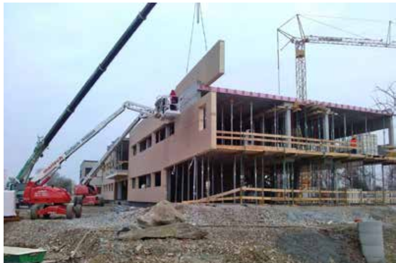
Wie auch die Biologische Station 1970-1971 wurde der Neubau 2014 bis 2015 in „Skelettbauweise“ ausgeführt.
