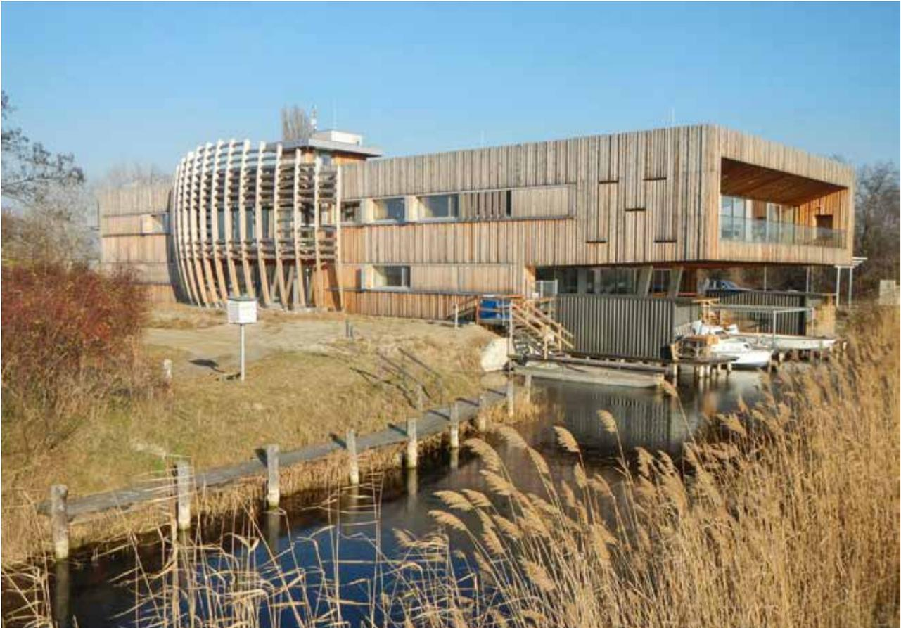
**Durch die besondere Architektur mit ungehobelten Lärchenbrettern passt sich das in Niederenergiebauweise ausgeführte Gebäude der Biologischen Station sehr gut der schilffreie Umgebung an (2017)**
