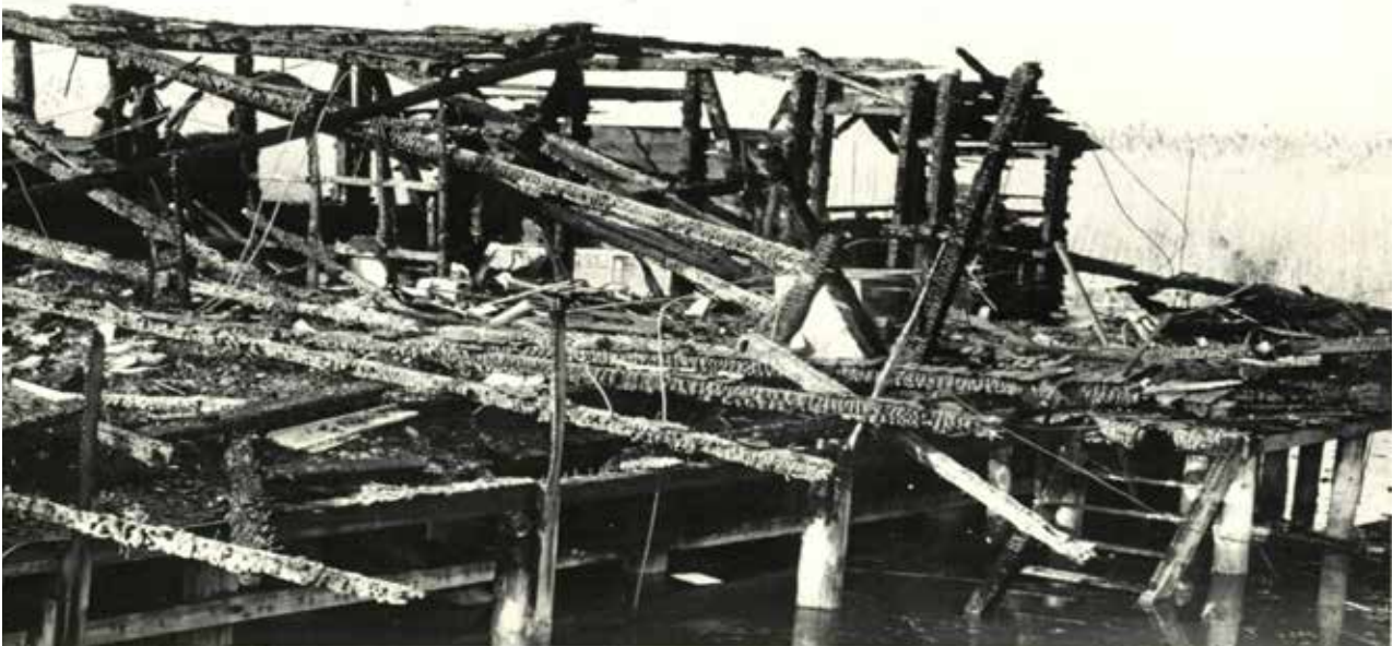
Das komplett zerstörte Hauptgebäude nach dem Brand 1960
