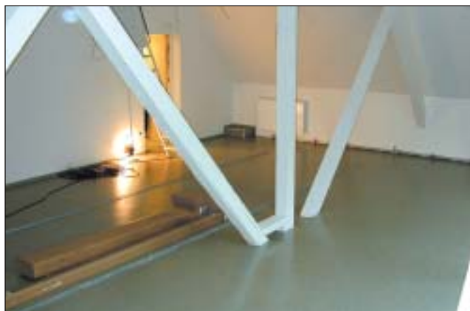
Abb. 6: Neu ausgebautes Dachgeschoss am Biologiezentrum 2002. Foto: Archiv Biologiezentrum.
