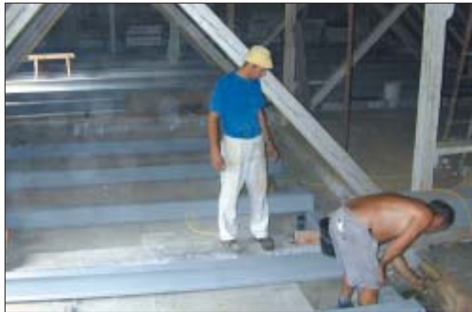
Abb. 5: Ausbau des Dachgeschosses 2001/2002. Foto: Archiv Biologiezentrum.
