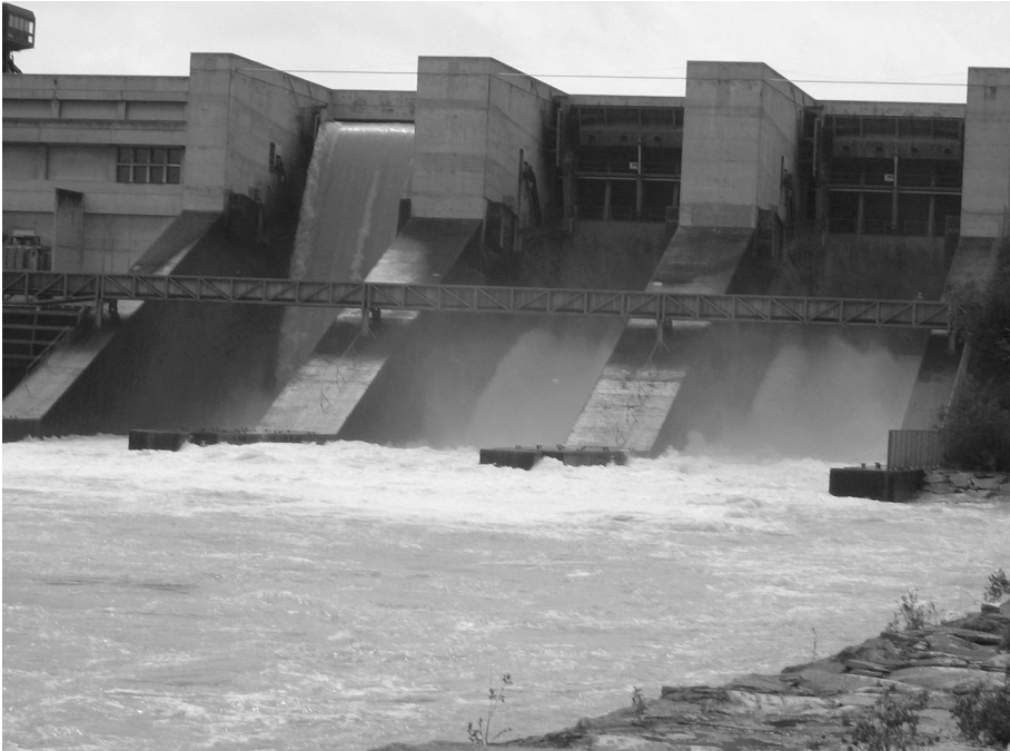
Abb. 4: Kraftwerk Traun-Pucking [N. BRANDSTETTER].
