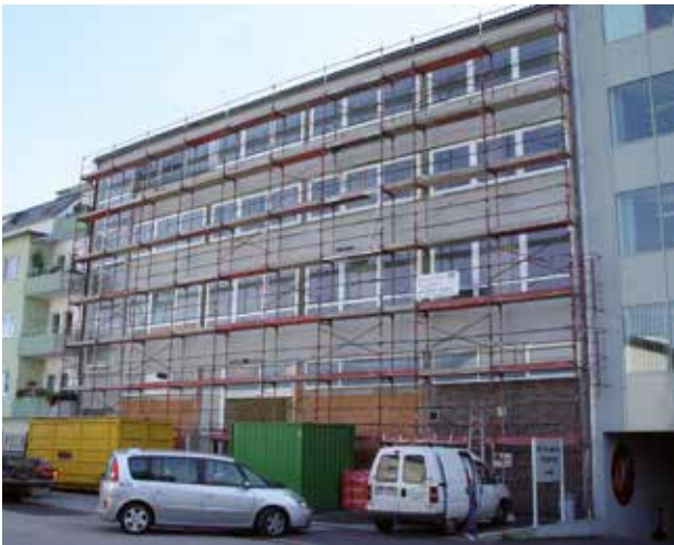
Abb. 89: An der Vorderfront des Depots Lindengasse wurden zwei Tore abgemauert, das verbliebene erneuert. Weiters wurden die Fenster ausgetauscht und die Fassade nach dem Stand der Technik isoliert (2007).
