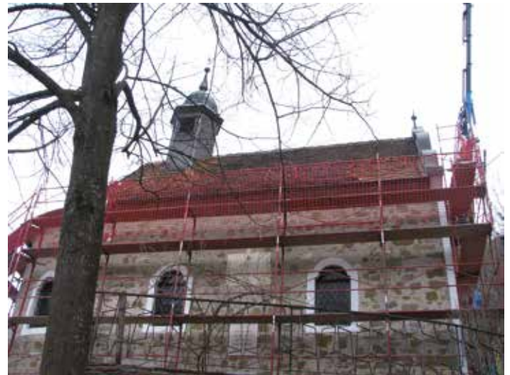
Abb. 9: Sanierungen von Gebäuden mit Kleinen Hufeisennasen stellen für diese Art eine Gefährdung dar. Eine fachkundige Begleitung durch Fledermausexpertinnen und -experten trägt maßgeblich zum Erhalt der Quartiere bei (© S. Pysarczuk).
