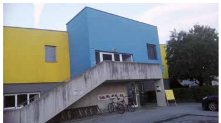
Abb. 3: Foto des Wochenstuben-Quartiers in Ottensheim. Die Kolonie nutzt den Spalt unter dem Flachdach (© J. Kropfberger).
