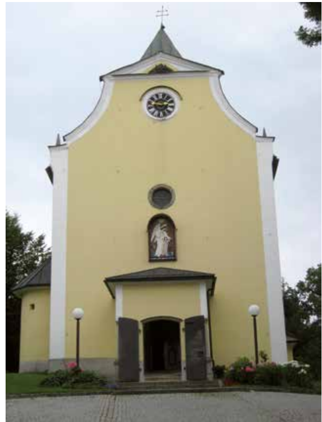
Abb. 5: Kirchen stellen wichtige Quartiere für Breitflügelfledermäuse in Oberösterreich dar. Bei Renovierungen ist es für den Erhalt der Quartiere entscheidend, dass Maßnahmen in Abstimmung mit Fledermausexpertinnen und -experten erfolgen (© J. Kropfberger).
