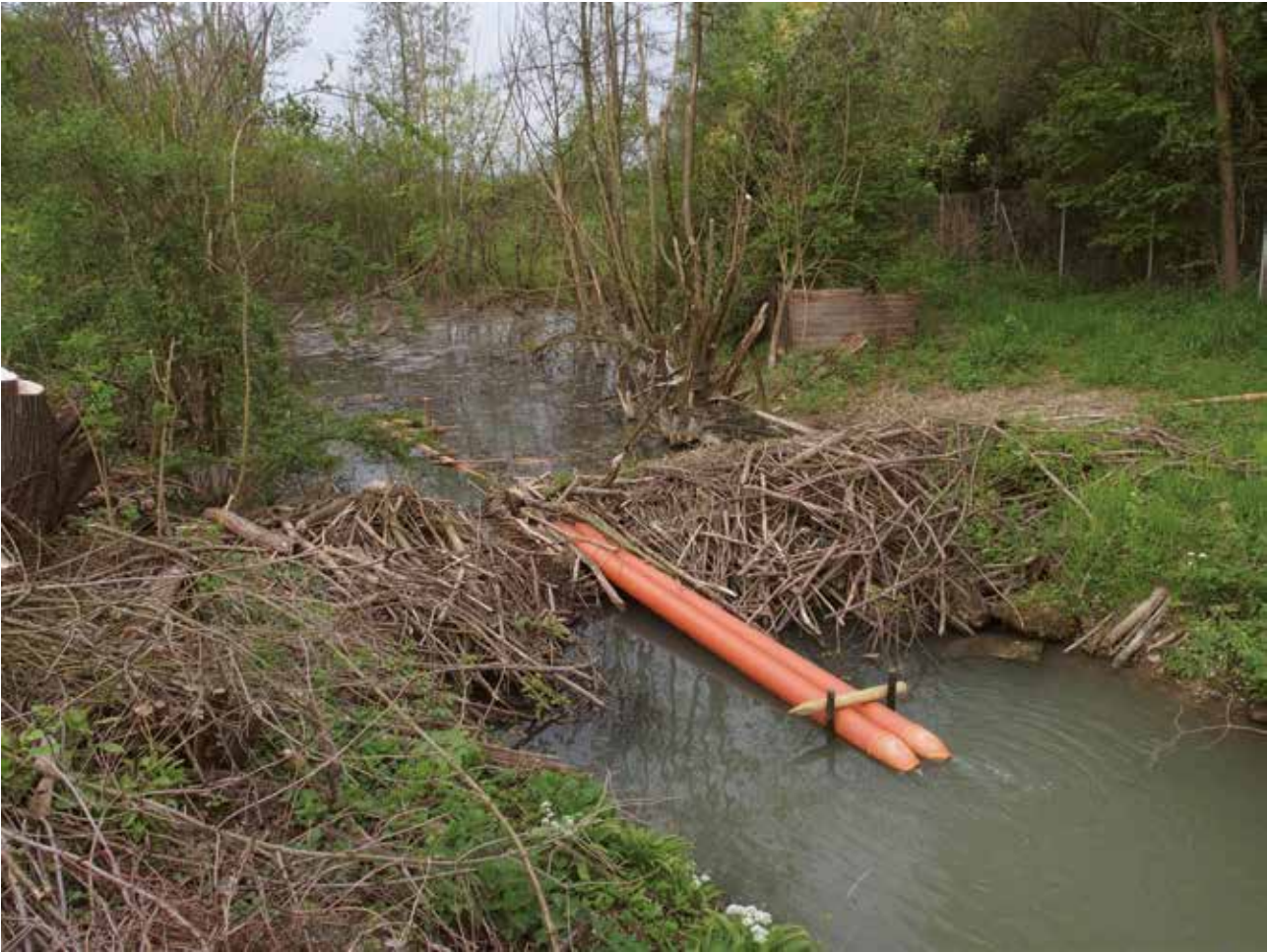
Abb. 15: Um den Wasserspiegel abzusenken wurde eine Dammdrainage eingebaut. Gräbt man zu diesem Zweck nur den Damm ab, würde der Biber diesen sofort reparieren bzw. wieder erhöhen (2015, Nettingsdorf, Gemeinde Ansfelden, OÖ; © B. Schön).
