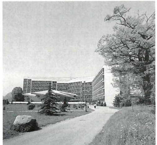
Abb. 1 Das Gebäude der Technischen Universität Zvolen
