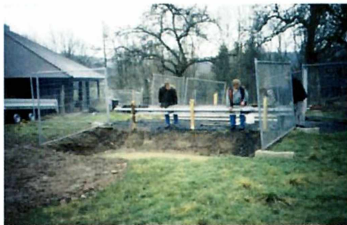
Abb. 6 Anbringung der Leitplanken, hier noch ohne Sichtblende. Ansicht aus Richtung der Grabenvariante
