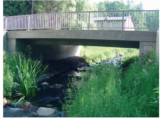
Abb. 2 Weitlumige Brücke über ein Fischottergewässer
