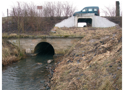
Abb. 9 Das gleiche Bauwerk entgegen der Fließrichtung aufgenommen mit dem vom Fischotter gut angenommenen Wechsel mitten durch den Stelztunnel
