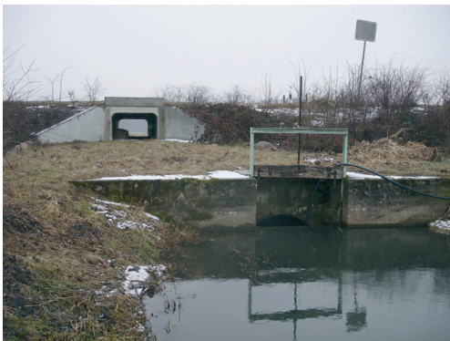
Abb. 8 Die für den Otter nur über Land passierbare Staueinrichtung mit dem die Straße unterquerenden Stelztunnel im Hintergrund
