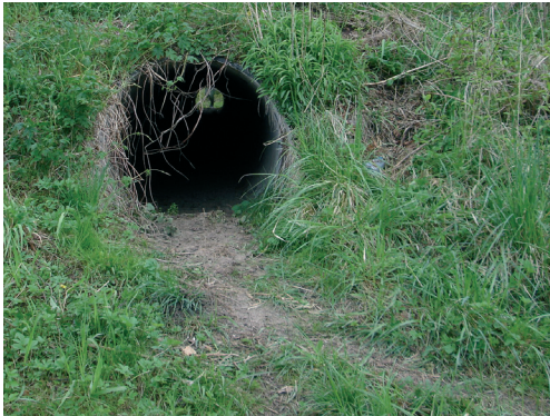
Abb. 6 Trockenröhre an der B 96 im Bereich der Schleuse Sachsenhausen mit deutlich erkennbarem Wechsel und Markierungshügel des Fischotters im Eingangsbereich
