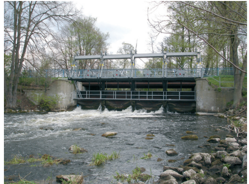
Abb. 7 Unfallschwerpunkt Komplexbauwerk Schleuse Sachsenhausen
