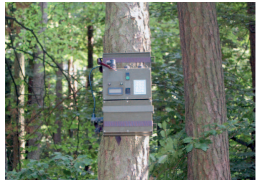
Abb. 3 Anbringung eines Batty-Gerätes mit Blei-Gel-Akku-Energieversorgung. (Foto: E. Gleich)
