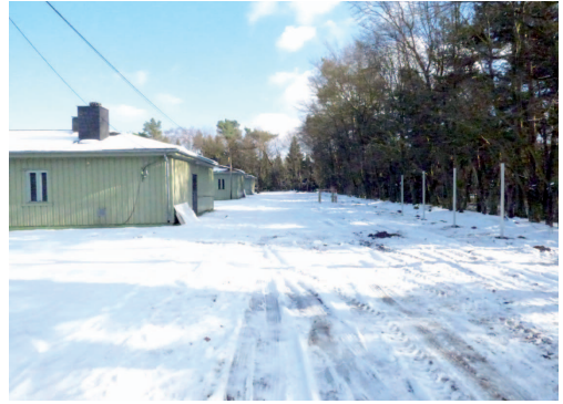
Abb. 5 Militärbaracken, vorbereitet als Flüchtlingsunterkunft. Die Zäunung verhindert unbefugten Zutritt zu den Gebäuden und zerschneidet den Lebensraum.
