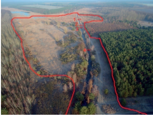
Abb. 17 NSG „Der Schlauch Burgkennitz“– Ableitergraben. 21.12.2016, Schrägaufnahme 45° Winkel, ca. 100 m Höhe, rote Linie Grenze des Reviers, 1–4 rote Balken Biberdämme
