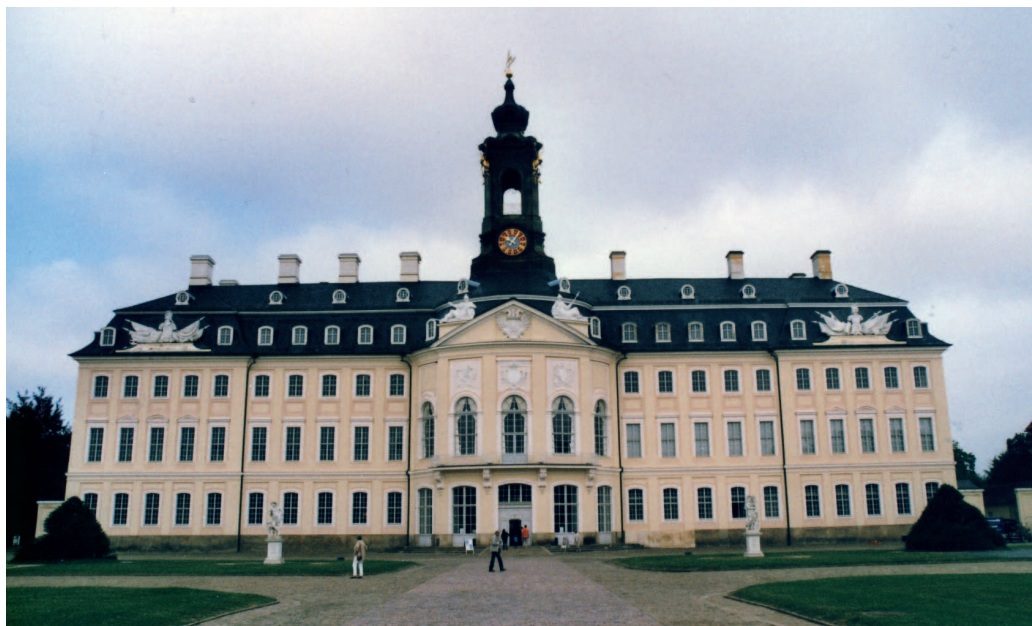
Abb. 8 Das Neue Jagdschloss Hubertusburg bei Wermsdorf, errichtet 1721–1753, ist das größte Jagdschloss Europas. (Foto: Bernd Bendix 2013)
