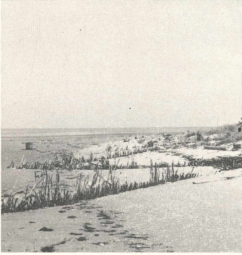
Abb. 4 a: Wassererosion 1973. Die übersandeten und überwachsenen Buschlahnungen (vgl. Abb. 1) werden an der SW-Seite der Turminsel freigelegt. Aufn.: H. Oelke.
