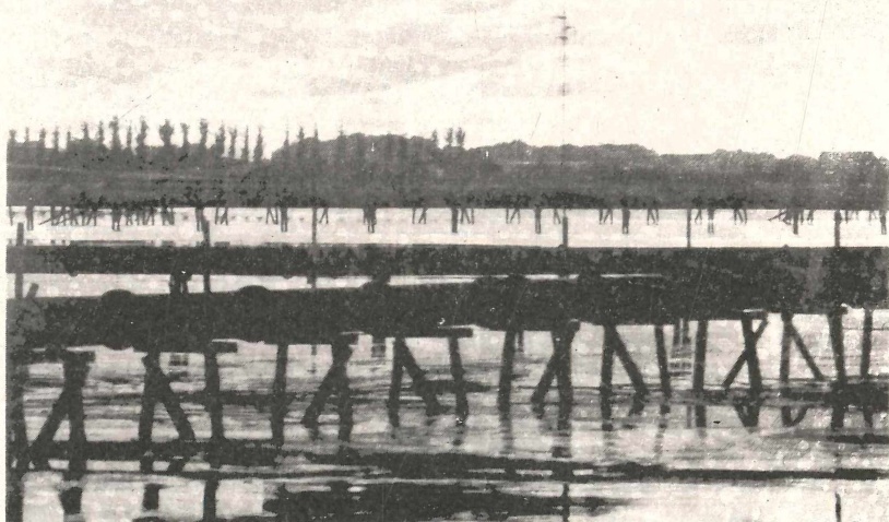
Abb. 3: Spülrohrleitungen im Überschlickungsgebiet Riepe. Im Hintergrund Teil der Autostraßen-Brücke über den Ems-Jade-Kanal bei Emden-Uphusen. 26.8.1975. Alle Photos vom Verf.
