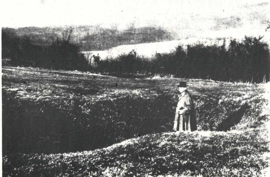
„Dolinentrichter“ auf den Kalkruthe-Wiesen bei Wangelnstedt (Kr. Holzminden) entstanden durch Deckeneinsturz darunterliegender Hohlräume infolge Auslaugung von Gipsnestern im Röt. Aufn.: Hamm 1932
