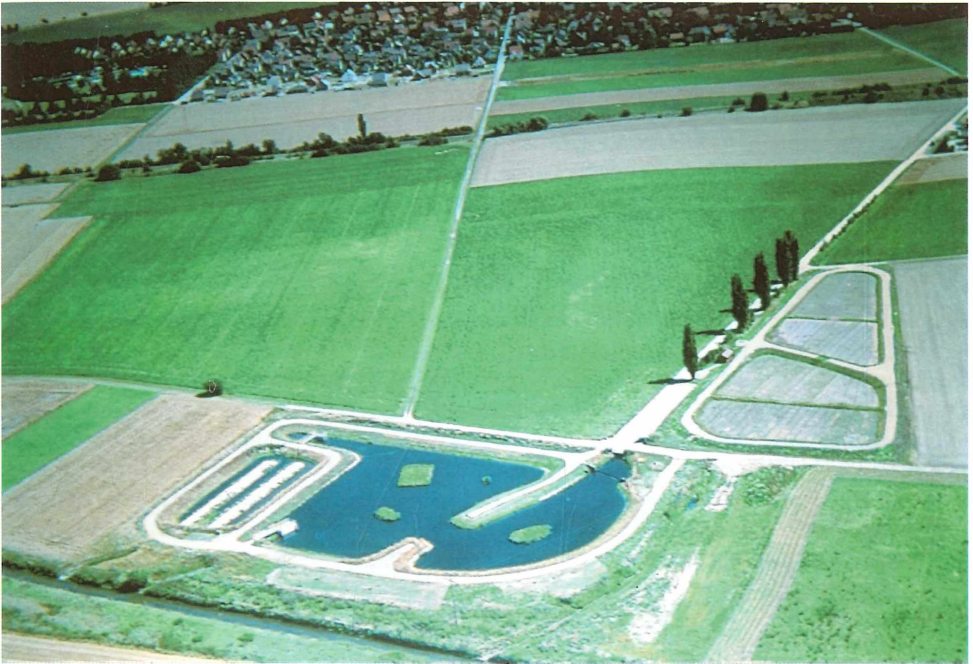
Luftbild 1 der Anlage: rechts Schilfkläranlage, linker Teil: Mischwasserbiotop mit Dämmen, Kunstinseln und vorbeilaufender Fuhse. Aufn. privat H.J. Kloster 1999.
