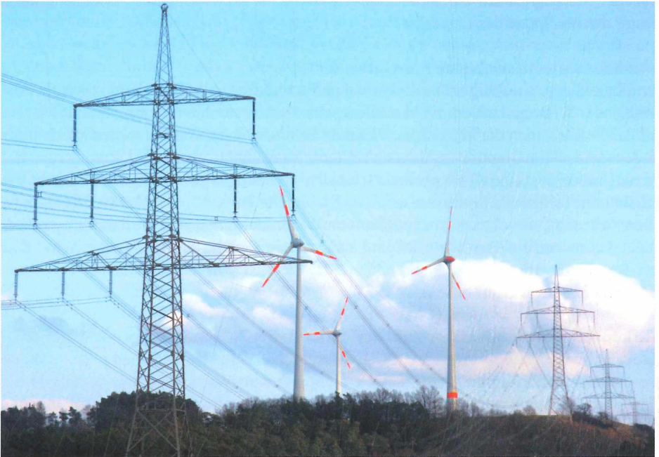
Abb. 3: Mit neuer Technik sollen 380 KV-Leitungen doppelt so viel Strom transportieren und sich dabei auf bis zu 210 °C erhitzen. Und die Vögel, die sich auf die Drähte setzen?
