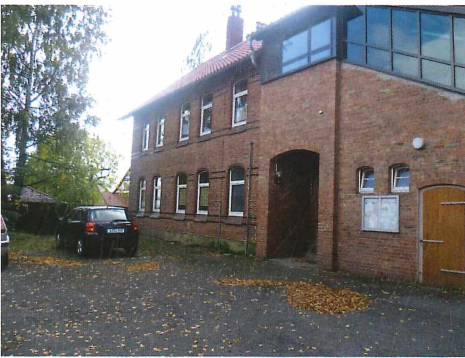
Abb. 10: Die ehemalige Schule und Verwaltungsstelle in Salzgitter-Reppner. Mehlschwalbenkolonie fort. Nester unter Hausdach sind entfernt. Photo: 11.10.2012.
