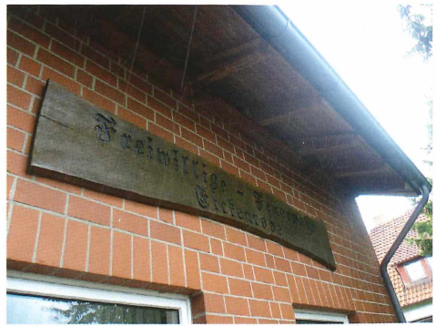
Abb. 11: Zu nahes Brett unter Hausdach als Schutz gegen Mehlschwalbennester. Mehlschwalben fort. Feuerwehrhaus Mödesse, Gemeinde Edemissen. Photo: 17.9.2012.
