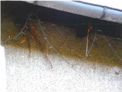
Abb. 14: Lampenbrücke einer Weihnachtsbeleuchtung gegen Mehlschwalbennester. Peine, Vöhrum, Nelkenweg 6. Bei Kontrolle 2011 flackern die Lichter in bunten Farben auf. Photo: 9.10.2012.
