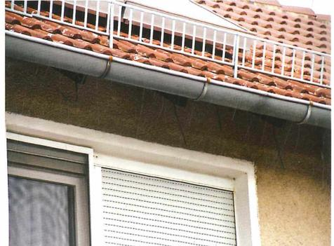
Abb. 15: Verschmutzte Alu-Bänder vor Mehlschwalbennestern (jetzt leer) Peine, Vöhrum, Zur Wasserburg 19-21. Photo: 9.10.2012.
