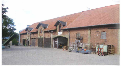
Abb. 2: Großkolonie von Mehlschwalben an W- und E-Seite des ca. 80 m langen, > 6 m hohen Betriebsgebäudes der Fa. Scheidt, Raiffeisen- Tier- und Gartenbedarf, Osterlinder Str. 6, Burgdorf/Hohenassel . Photo: 11.10.2012.
