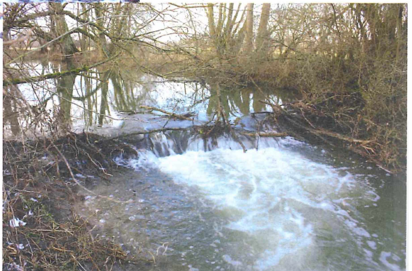
Abb. 7 Damm im Fugenwinkel.
