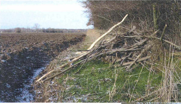
Abb. 12 Mittelbau, dessen Dach bis an den Acker reicht.
