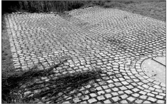
Abb. 3 Gepflasterter Notüberlauf
