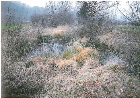
Abb. 8: Trotz seiner eintönigen Bauweise hat der Binnenkanal einen relativ abwechslungsreichen Charakter.
