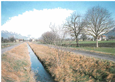
Abb. 3: Deutlich sichtbar ist die geringe Wassertiefe in den mit Beton verbauten oberen Abschnitten des Seveler Baches.
