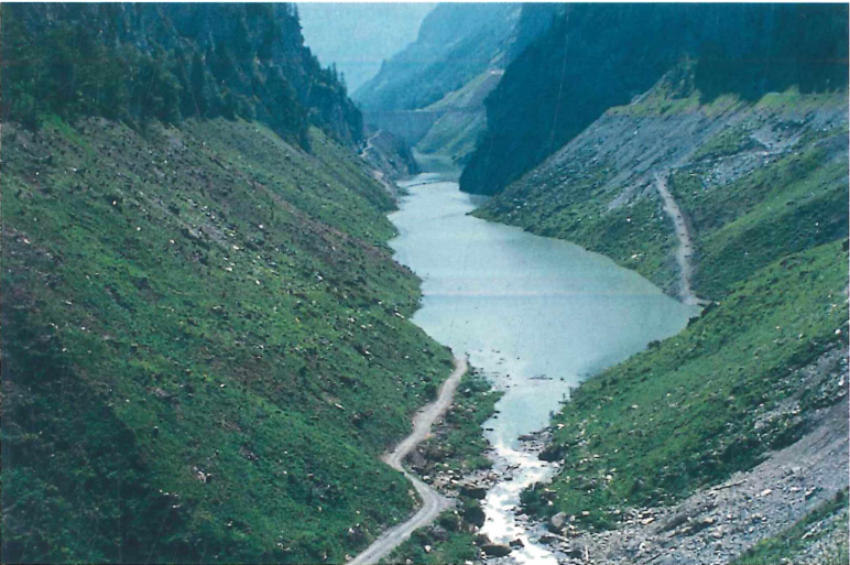
Abb. 9: Der Speichersee füllt sich langsam mit dem zurückgestauten Wasser. (Foto: KSL)
