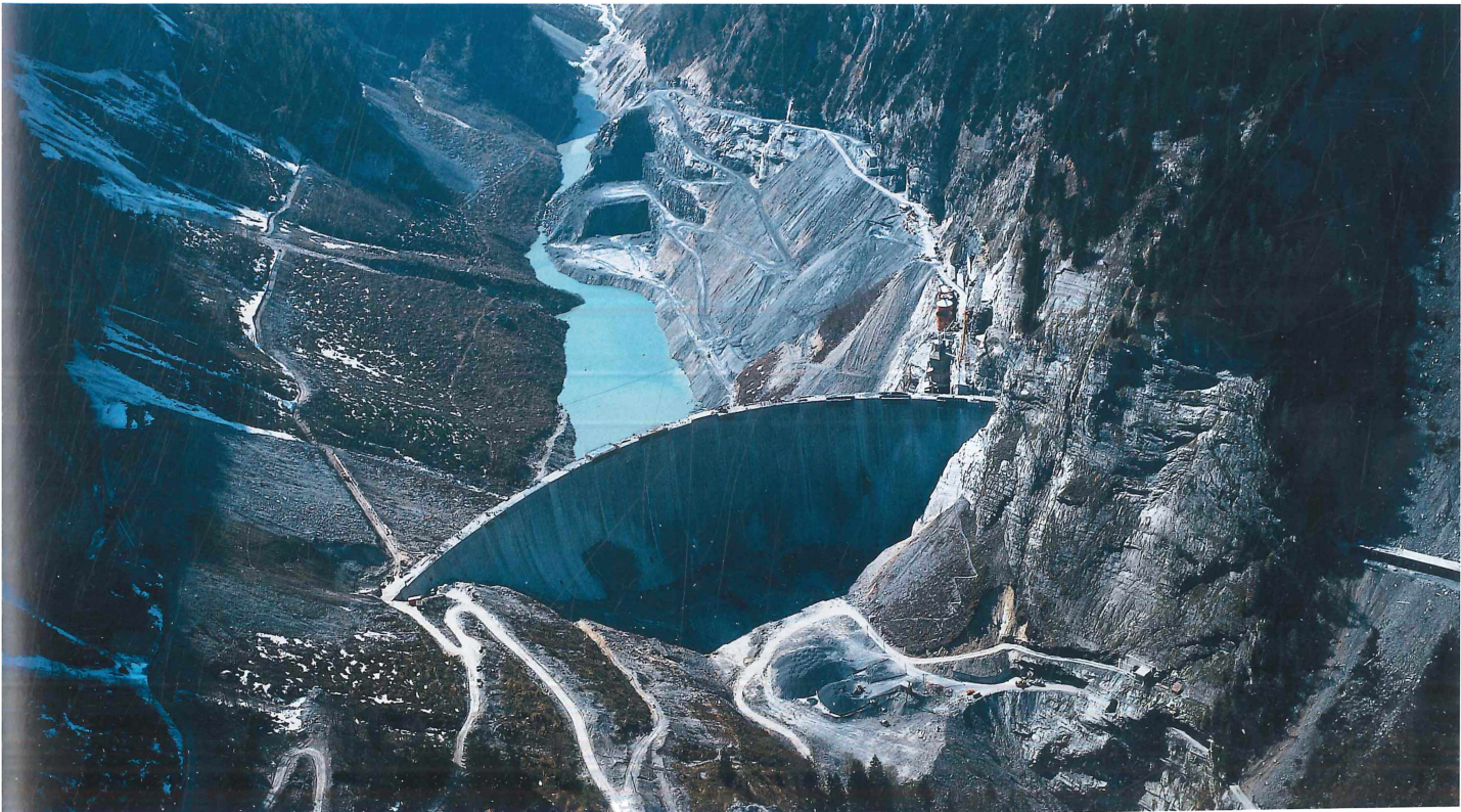
Abb. 8: Mit dem Bau des Speichersees wurden die Verbindungen im Gewässernetz unterbrochen.
