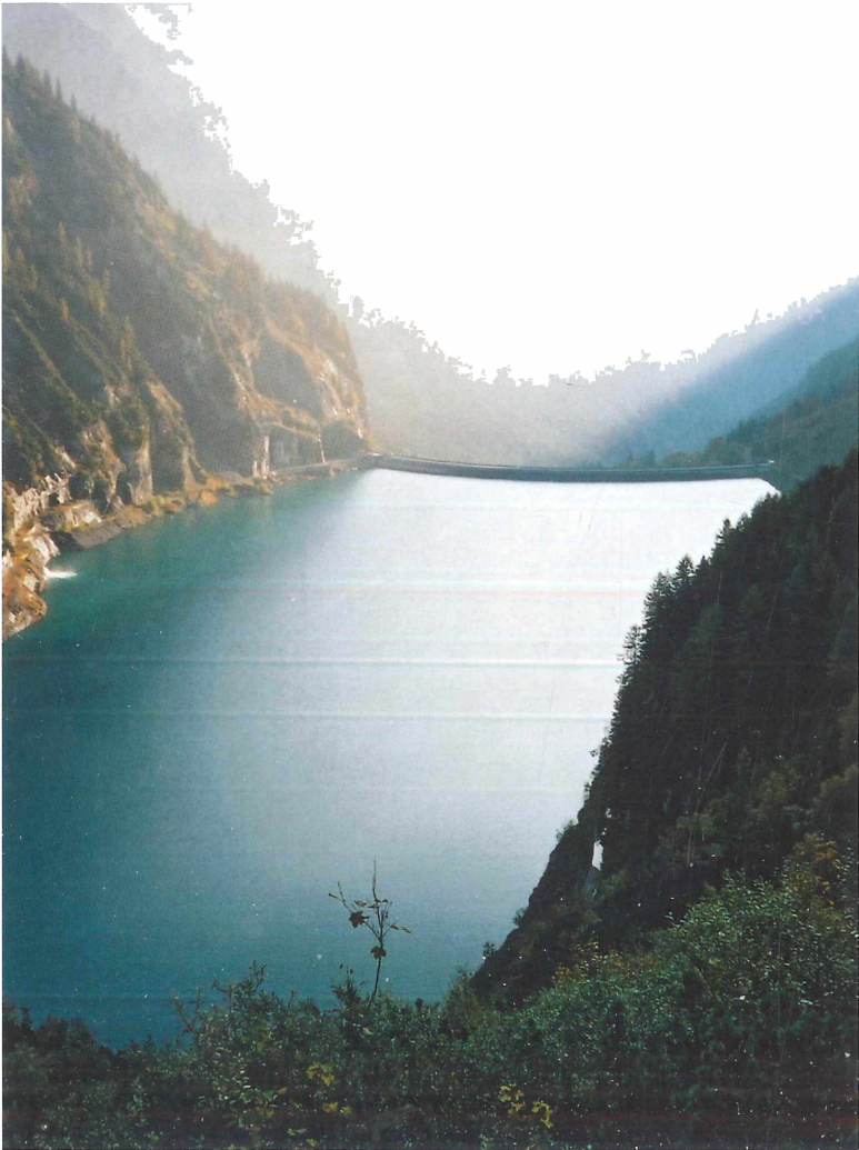
Abb. 10: Der Speichersee im Herbst 2001
