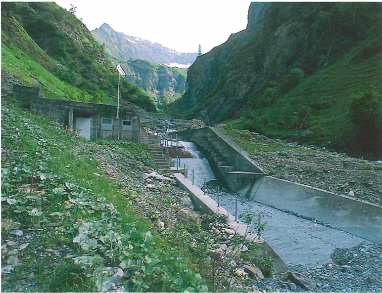
Abb. 3: Ein Teil des Wassers der oberen Seez wird durch Stollen in den Gigerwald-Stausee übergeleitet. Im Bild die Wasserfassung Lavtina (Foto: R. Schwitter)
