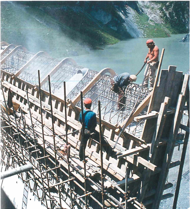
Abb. 4: Die Arbeit an der Staumauer war nicht ungefährlich. Bau der Hochwasserentlastung (Foto: KSL)
