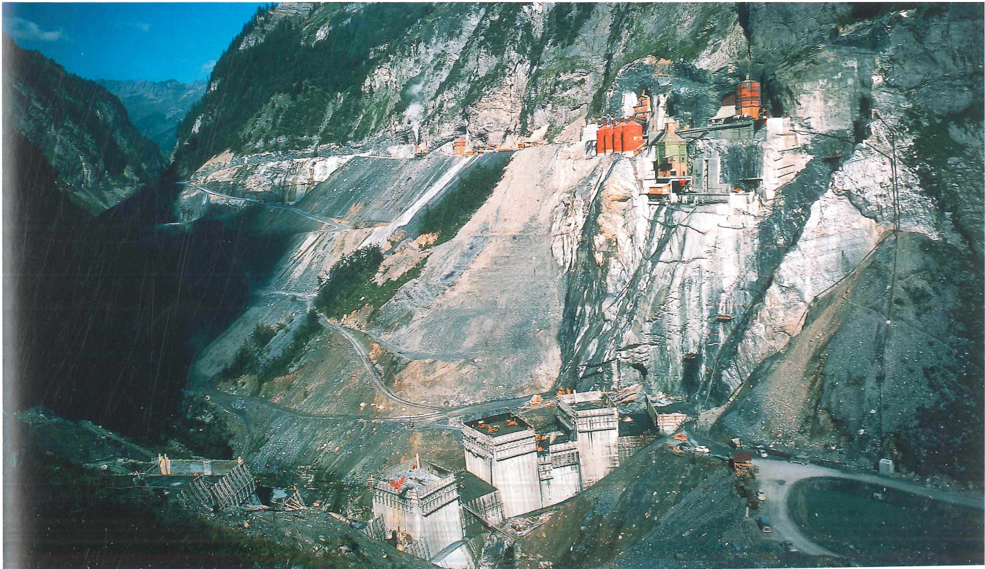
Abb. 5: Stand des Mauerbaues Sommer 1974 (Foto: KSL)
