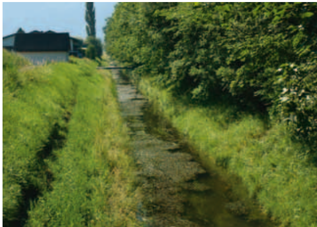
Abb. 18 Die neugestaltete Binnenkanalmündung bietet einen hohen Anteil an Strukturen und damit verschiedene Lebensräume für das Makrozoobenthos. (Foto: P. Baumann)
