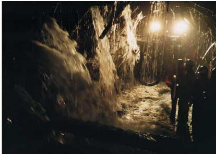
Abbildung 3: Massive Bergwasserzutritte beim Tunnelbau
