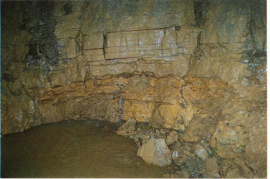
Bild 1: Wasserführender „Gelbkalk“ im Rauhebergtunnel an der Grenze Buntsandstein/Muschelkalk (Foto: J. HANISCH)
