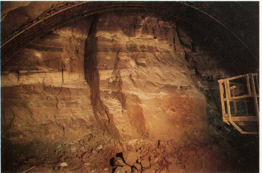
Bild 2: Sohlbergtunnel: Hangzerreißungsspalten im Solling-Bausandstein
