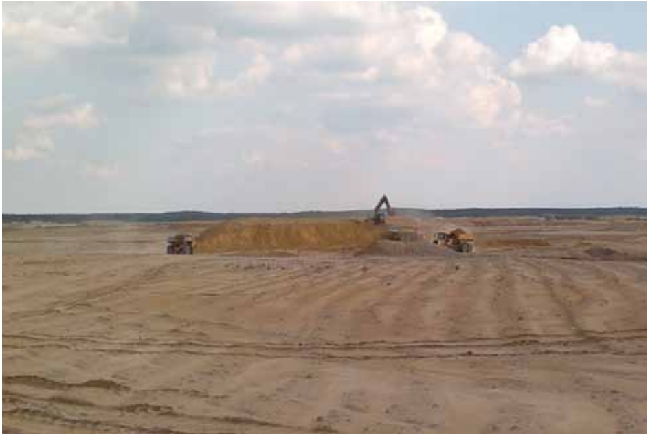
Abb. 2 Auftrag sandiger Substrate mit mobiler Erdbautechnik. Foto Uta Masch
