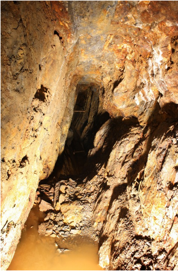
Abb. 6 1. Sohle der Goldgrube Görlitz, etwa 30 m westlich des 1. Gesenks, Blick nach W. Deutlich sind noch nicht beräumte Verbruchmassen und die Neigung des Stollens nach Süden (links) zu erkennen. An der rechten Stoßseite treten weiße Calcitsinterfahnen auf. Foto O. Tietz, März 2011
