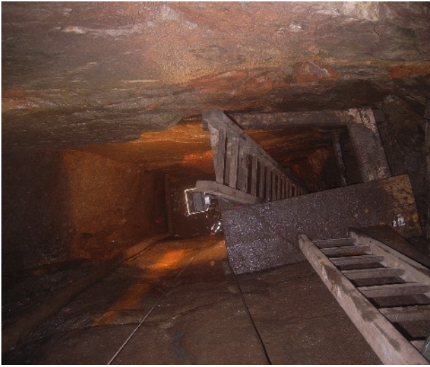
Abb. 8 Blick in den saiger abgeteuften Schacht des 2. Gesenks mit Zwischenbühne zur Aufnahme der Fahrt (Leiter). Foto V. Scholz (Oberbergamt Freiberg), Januar 2011
