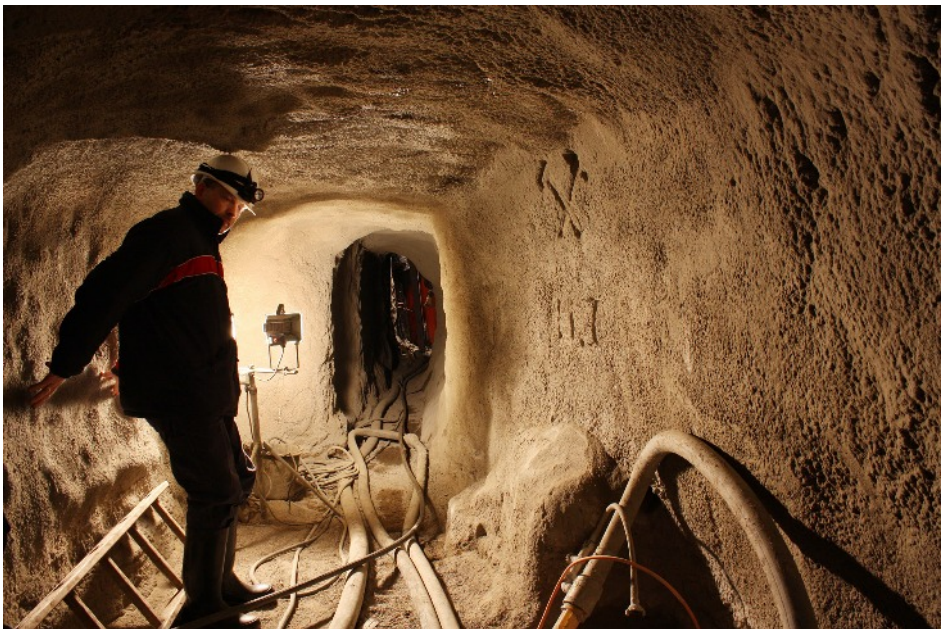
Abb. 5 Mit Spritzbeton ausgebaute 1. Sohle beim 1. Gesenk (dieses befindet sich hinter der Wandseite mit dem Hammer- und Schlägel-Zeichen) vom März 2011. Blick nach W. Foto O. Tietz, März 2011
