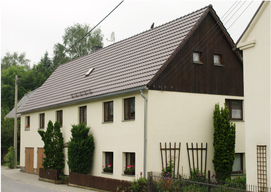
Abb. 3: Feurichs Wohnhaus in Göda im sanierten Zustand 2017, bewohnt von seiner Enkelin. Foto: Michael Kallmeyer
