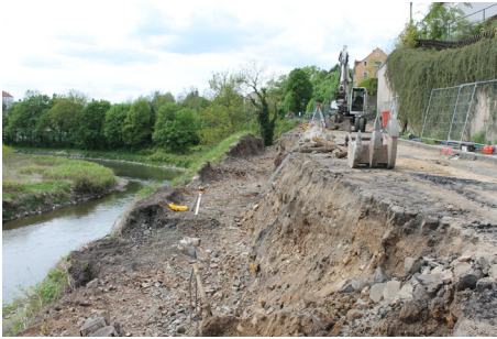
Abb. 3: Die Baugrube für die neue Stützmauer entlang der Rothenburger Straße im Mai 2015, Blick nach WSW.
