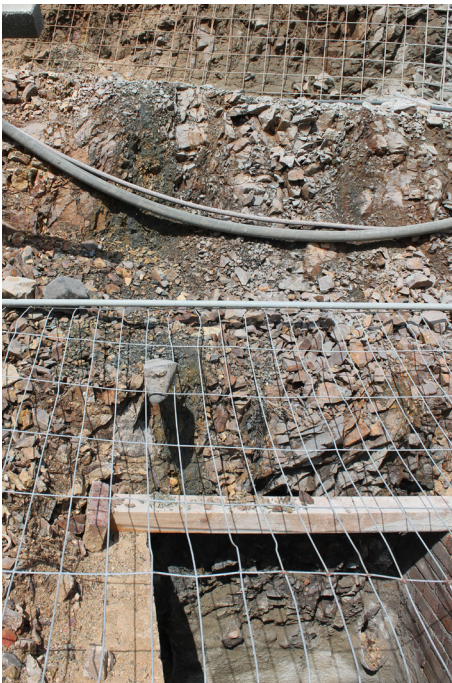
Abb. 5: Die oberflächennah durch die Baugrube aufgeschlossene Gangzone der Goldgrube im Juni 2015. Am unteren Bildrand ist der quadratische Ziegelbau des Brunnens aufgedeckt.
