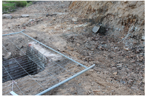
Abb. 4: Der in der Baugrube der Stützmauer aufgedeckte quadratische Ziegelschacht des Brunnens (unter dem Gitter). Auf der rechten Bildseite Böschungsanschnitt mit der dunkel verfärbten, oberflächennahen Gangzone der Goldgrube im Mai 2015.
