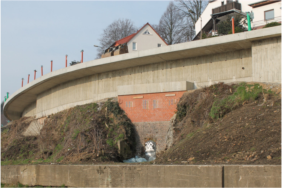
Abb. 1: Fertiggestellte Stützmauer an der Rothenburger Straße in Görlitz im Februar 2016. In der Bildmitte ist unter dem Ziegelmauerwerk die Stahltür zu erkennen, die als Zugang zum Brunnenschacht und zum Mundloch des historischen Bergwerkes Goldgrube dient.
