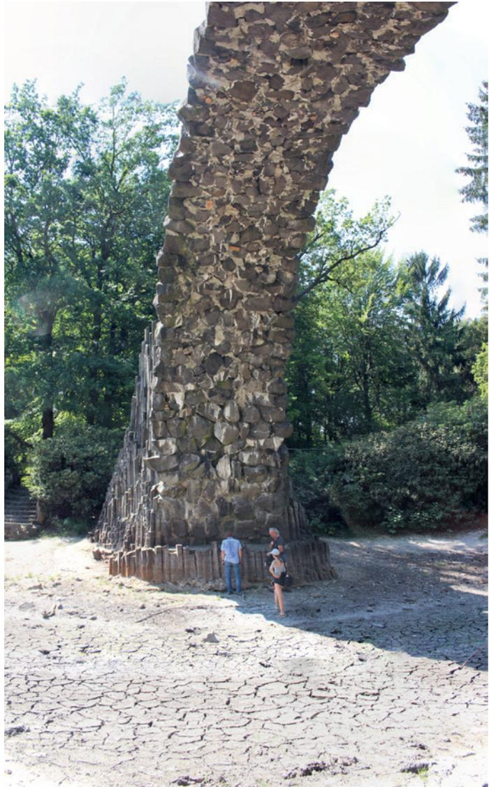
Abb. 1: Die Rakotzbrücke mit dem südlichen Fundament und dem abgelassenen Rakotzsee. Letzteres ermöglichte eine zerstörungsfreie Probenahme, da auch herabgefallene Basaltgesteine vom Seegrund untersucht werden konnten. Blick nach SW. Foto: O. Tietz 1.8.2018
