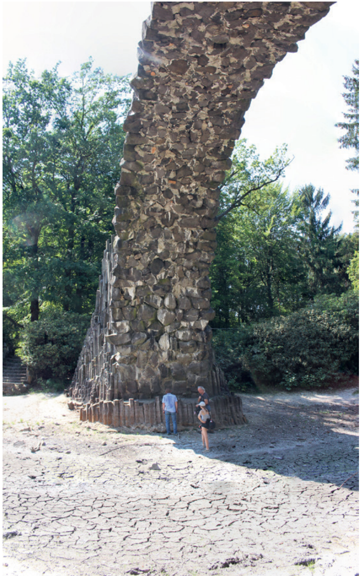
Abb. 1: Die Rakotzbrücke mit dem südlichen Fundament und dem abgelassenen Rakotzsee. Letzteres ermöglichte eine zerstörungsfreie Probenahme, da auch herabgefallene Basaltgesteine vom Seegrund untersucht werden konnten. Blick nach SW. Foto: O. Tietz 1.8.2018
