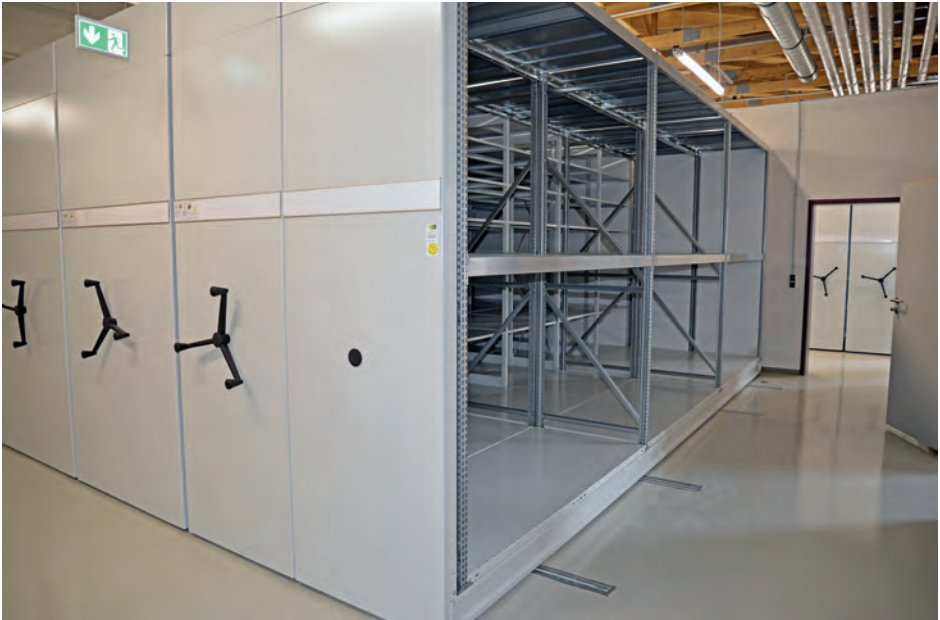
Abb. 10: Einbau der neuen Regalsysteme im 2. Archivraum, der für die naturkundlichen, geologischen und regionalgeschichtlichen Sammlungen vorgesehen ist. Stand Oktober 2020. Foto: Th. May 2020
