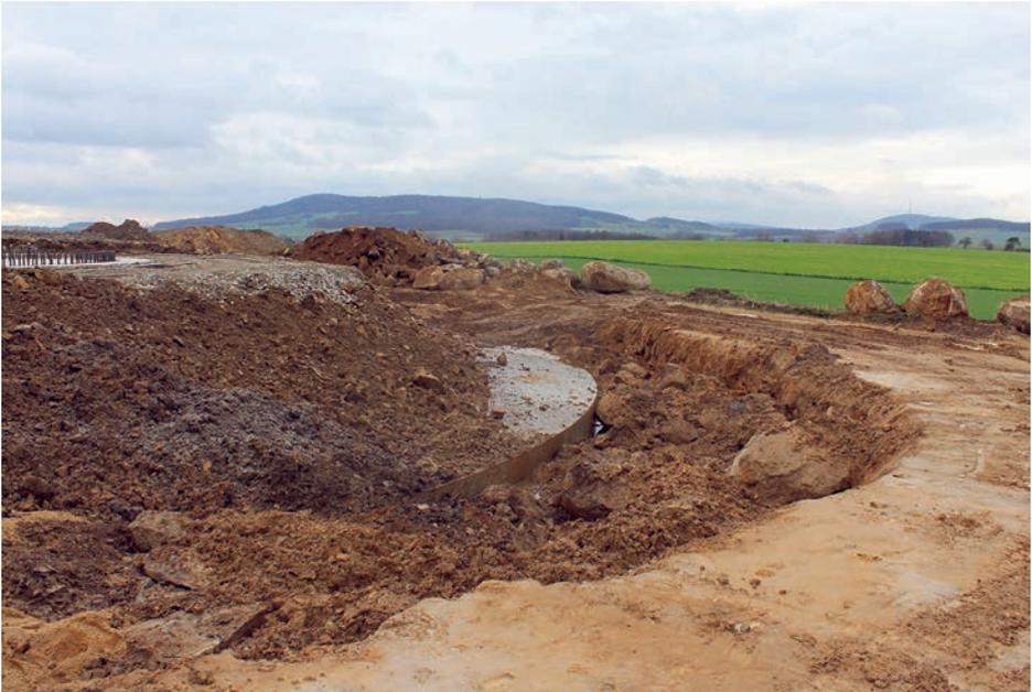
Abb. 1: Im Windpark Reichenbach wird die Baugrube der Ersatz-WKA mit Lockermaterial und großen Gesteinsblöcken aufgefüllt. Weiteres Gestein aus dem Aushub lagert am Feldrand (im Hintergrund: in der Bildmitte der Rotstein bei Sohland und rechts der Löbauer Berg mit der Sendeanlage auf dem Schafberg-Gipfel). Aufnahme im November 2017, Blick nach SW. Alle Fotos (bis auf Abb. 3) Th. Giesler
