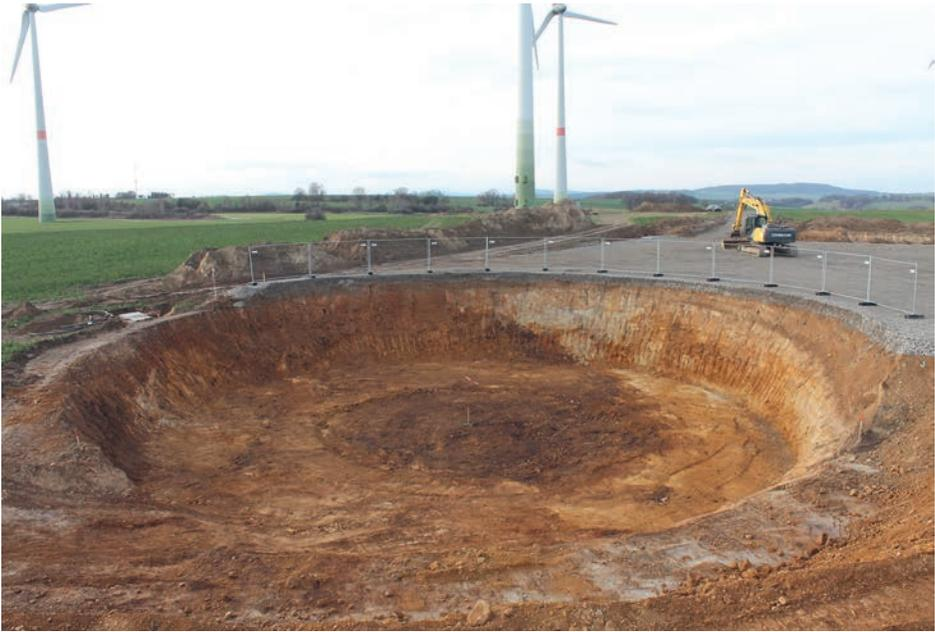
Abb. 4: Die Baugrube der Ersatz-WKA bei Charlottenhof (Gemeinde Schöpstal) im Dezember 2019. Aufnahme von der östlich angrenzenden Halde mit dem Aushubmaterial.
