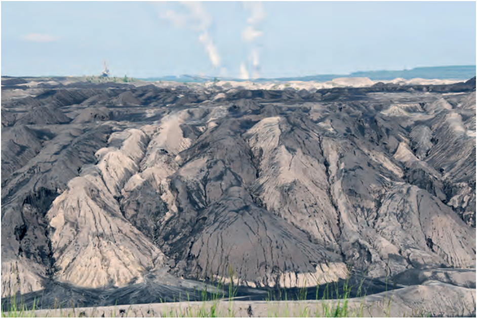
Abb. 10: Brückenkippe mit dem Randschlauch im Südosten des Tagebaues Reichwalde. Eine Überdeckung dieser mit pleistozänem Material erfolgt ab 2025 mittels einer Bandanlage und eines Absetzers. Beides ist links im Hintergrund zu sehen (vergleiche Ziel 14). Foto: F. Brozio, 20.5.2025
