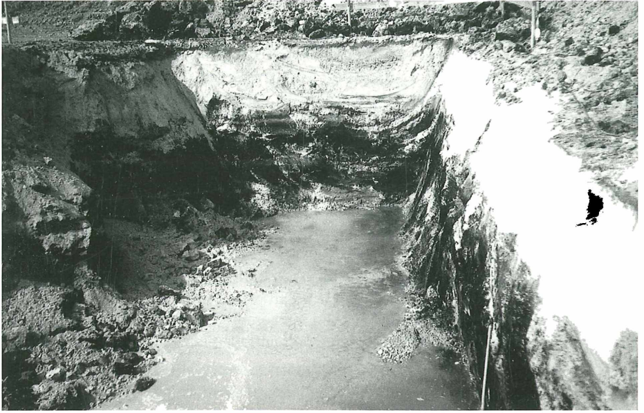
Abb. 4: In einer Baugrube in Egling a.d. Paar kam Alm in einer 1,5 m mächtigen Schicht (über Torf) zum Vorschein. Der Alm, feinkörnig und unverfestigt, kann leicht zwischen den Fingern zerrieben werden.
