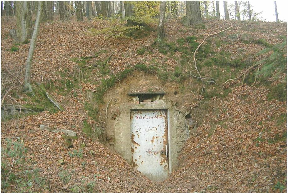
Abb. 12: Eingang zum Keller von Zusamzell. Der Lagerkeller liegt ca. 1,5 Meter unter dem Niveau des Eingangs.
