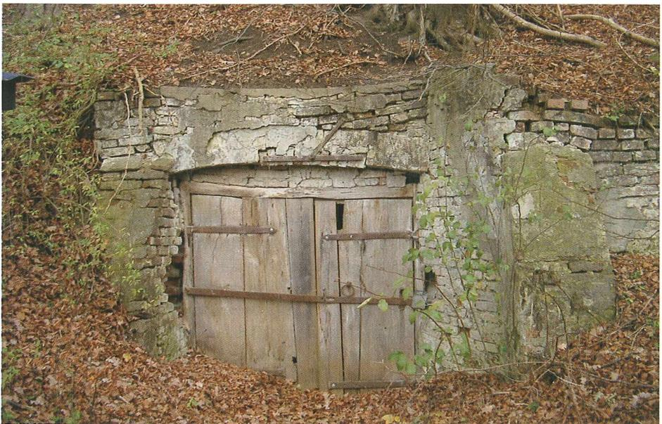
*Abb. 7: Eingang zum Keller Altenmünster. Vor allem Wurzelwerk führt zur Verschiebung der Ziegel im Kellergewölbe und leitet damit den Verfall ein.*
