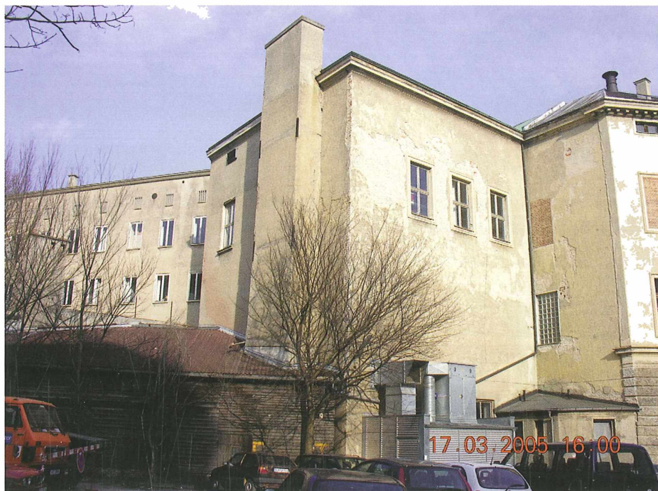
Abb. 2: Nordseite der Theaterwerkstätten, an der sich die Abendsegler aufhalten. Die Gebäudehöhe wird auf 18 Meter geschätzt.
