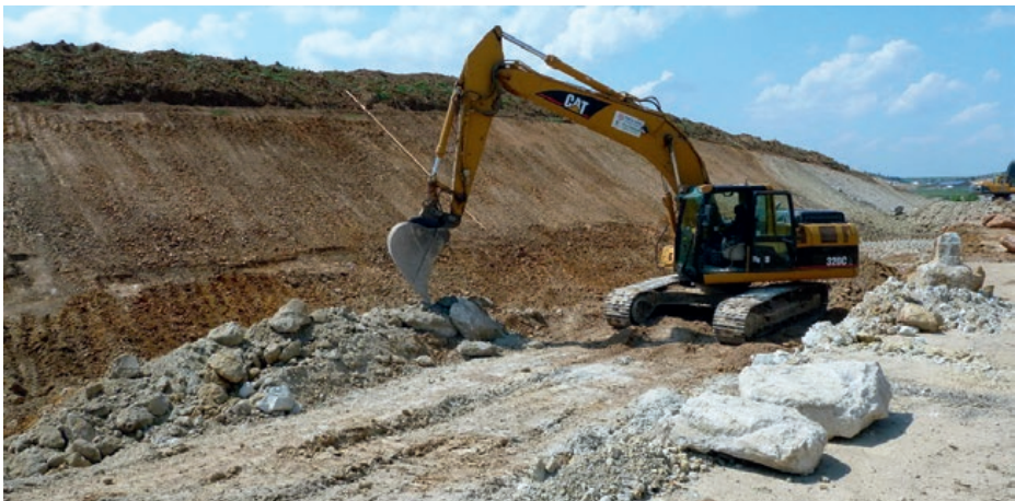
Abb. 5: Große Brocken aus Malm-Kalk finden oft Abnehmer, weshalb sie der Baggerführer vorsorglich beiseitegelegt hat.
