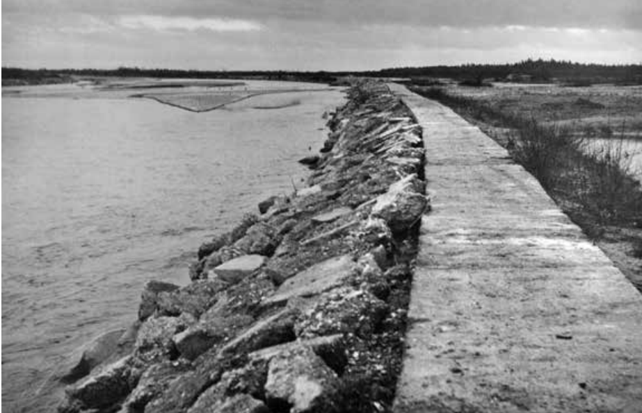
Abb. 4: Kanalisierter Lechabschnitt im „Stadtwald Augsburg“ zwischen Mering und Haunstetten. Noch liegen größere Kiesbänke im begradigten und durch ein Betonkorsett von der Aue getrennten Flussbett. (Foto: November 1934, Dr. Heinz Fischer Sammlungen, © Stadt Königsbrunn)
