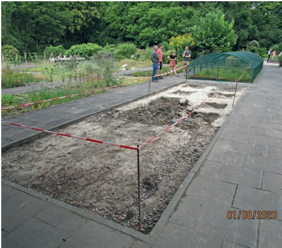
Abb. 9: Baustelle des geplanten Kalkflachmoorbeetes
