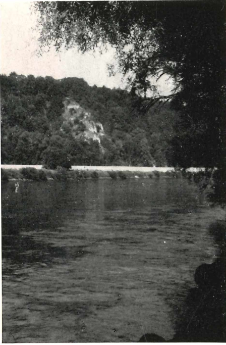
Finkenstein — Blick über die Donau (unterhalb des Felsens der neue Damm der Stautufe Bittenbrunn)
