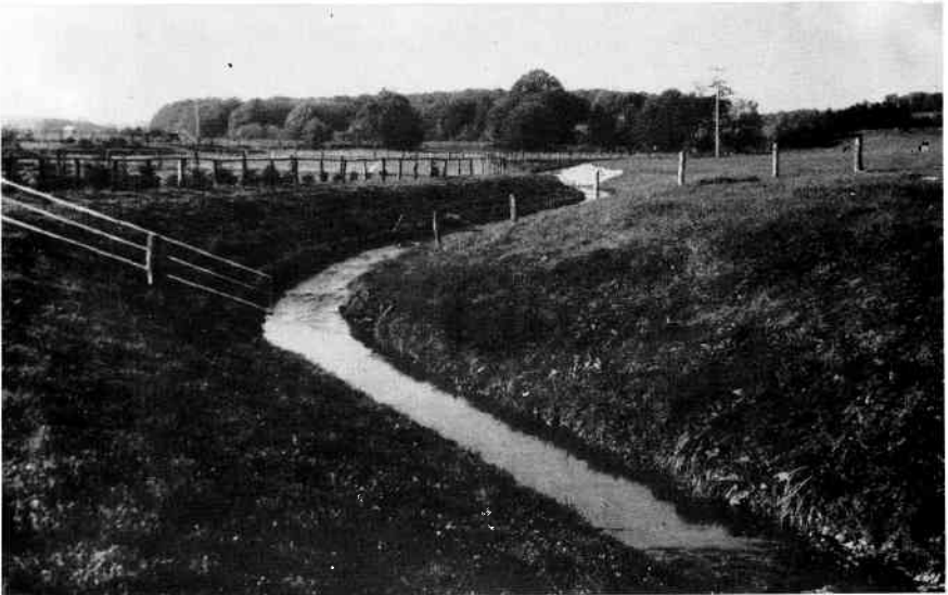
(4) In den letzten Jahren im Rahmen der Flurbereinigung ausgebauter Lichtebach in der 'Senne': ökologisch tot
