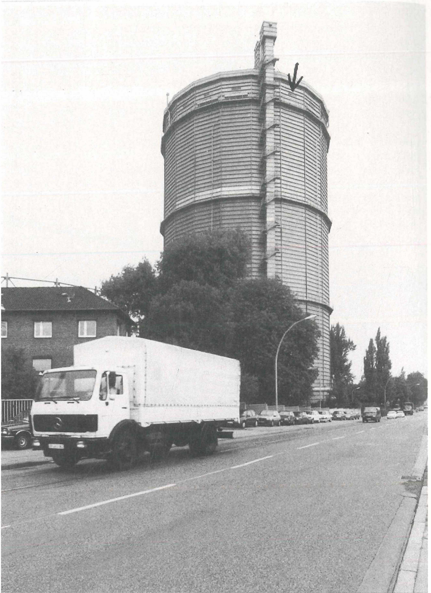
Abb. 2 Scheibengasbehälter der Stadtwerke Bielefeld GmbH. Foto: Rolf Siebrasse.
