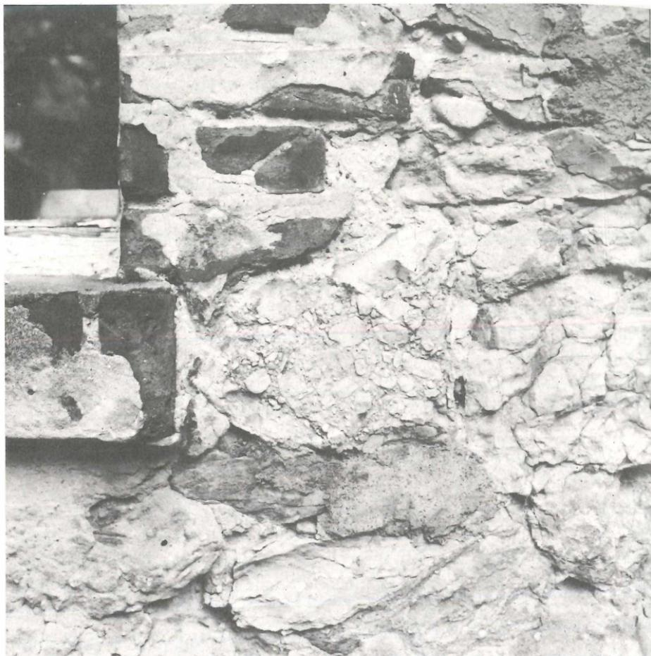
Abb. 2: Mauerwerk mit phacoidisierten Bruchsteinen an der Hauswand des Hofes Eikenbusch;
