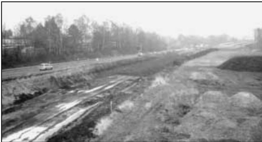
Abb 1: Der 1. Abbaubereich nahe der Autobahn. Blickrichtung von Nordwest nach Südost. Deutlich erkennbar ist die bis um 5 - 6 m mächtige lehmhaltige Sandüberdeckung.
