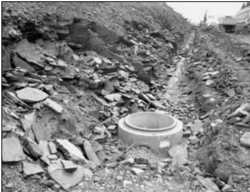
Abb. 7 : Wieder Ärger auf der Baustelle gegen Ende Juni 2006. Zum Leidwesen der Arbeiter wurde der Graben an verschiedenen Stellen zugewühlt, bevor die Rohre in das Sandbett eingerüttelt waren. Auf diesem Bild ist der Schaden teilweise schon wieder behoben gewesen.
