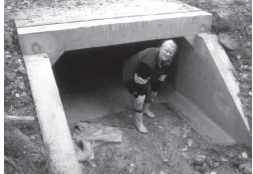
Almut Kroll in einem neuen Tunnel am Moorbach.
