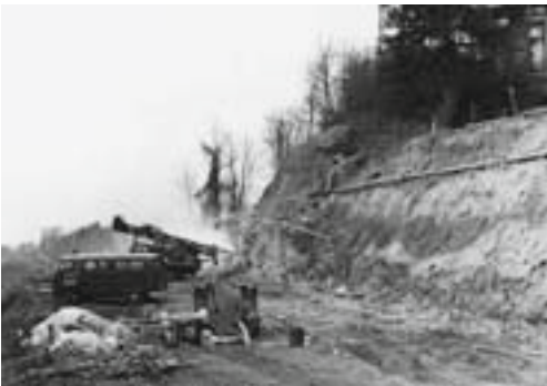
Abb. 5: Versturz mit Restlehm bildungen an der Felsböschung der Baustelle Ostwestfalendamm (1973/1974) Abschnitt Johannisberg. Bereich der ehemals gipsführenden Schichten des mittleren Muschelkalkes.
