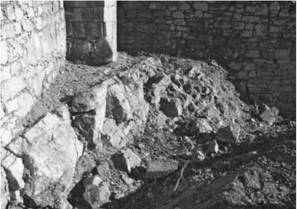
Abb. 3: Die Schichtkämme des Trochitenkalks stoßen in einem spitzen Winkel auf die Ostmauer des Zeughauses.
