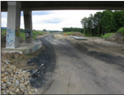
Abb. 5: Blick unter die Überführung der Bahnhofstraße an der A33-Brücke in Steinhagen in Richtung Osten auf die plattgewalzten Tonsteine aus Bad Oeynhausen vom Bau der dortigen A30-Ortsumgehung.
